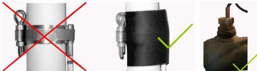
Obr. č. 8 – zapojení teplotních čidel
